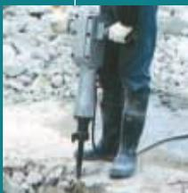
Высокая мощность для тяжелых условий работы. Антивибрационная рукоятка. Возможность использования стандартных долот (30 мм). Система автоматического отключения щеток.
